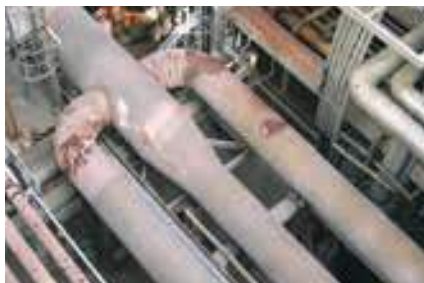
Визуальное и ИК-изображение прорыва огнеупорного покрытия воздуховода
