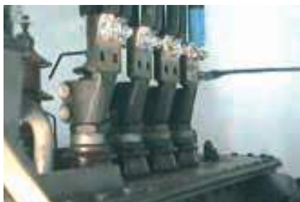
Верхняя часть трансформатора; высоковольтное соединение
