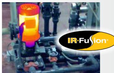
3,5-дюймовый сенсорный ЖК-экран оснащен технологией IR-Fusion™, которая позволяет совмещать изображение в видимом спектре с инфракрасным изображением для более удобного обнаружения проблем. Просто проведите пальцем по экрану, чтобы изменить настройку.
