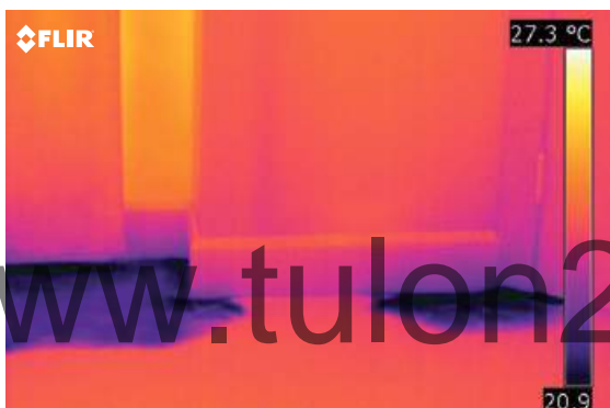
Проникновение влаги в пол, невидимое для человеческого глаза, хорошо заметно на термическом изображении.
