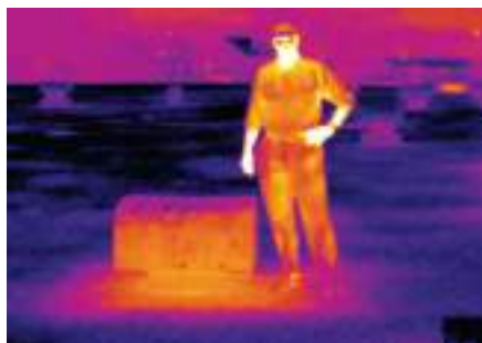
Рис. 5-64. Кроме влажной теплоизоляции, теплый след на крыше могут давать многие объекты, такие, как козырьки вентиляционных каналов системы ОВКВ.
