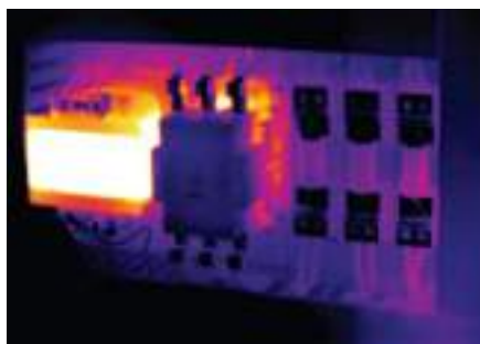
Рис. 5-18. Возможный дисбаланс нагрузки на правом дальнем предохранителе можно не увидеть, если не отрегулировать уровень и диапазон изображения.
