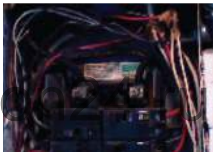
Рис. 5-7. Соединение с высоким сопротивлением или неисправный элемент автоматического разъединителя в жилых зданиях просто увидеть с помощью тепловизора, но не видно на обычном изображении.
