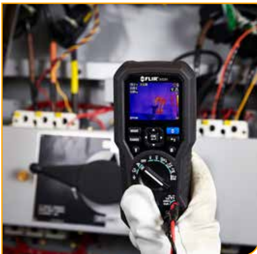
Тепловизионная проверка электрощита
