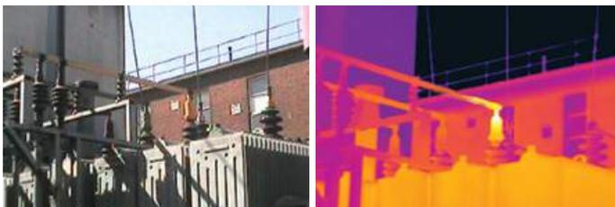
*Полный осмотр подстанции позволит быстро выявить участки со слишком высоким сопротивлением в соединениях. Ни одна другая технология для профилактического технического обслуживания не может сравниться с тепловидением по эффективности при проверке электрических установок.*
