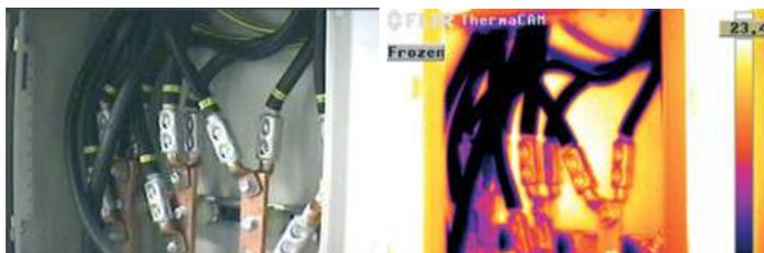
*Это ИК-изображение выглядит достаточно странно, если не учитывать обстоятельства, при которых оно было сделано. Нагрузка на кабели отсутствует. Они расположены в теплом помещении, и неокисленные металлические поверхности отражают высокую температуру окружающей среды*
